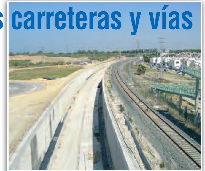
Obras en la vía férrea a su paso por Puerto Real
